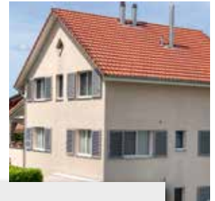
Vorher: Tonziegeldach mit Moos und Schwarzalgenbefall. Nachher: Dach ca. ein Jahr später.
