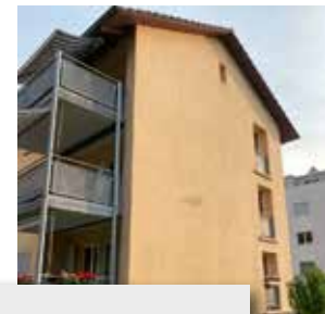
Algen und Flechtenbefall Fassade (Bild oben), Fassade ca. ein Jahr später (Bild unten).
