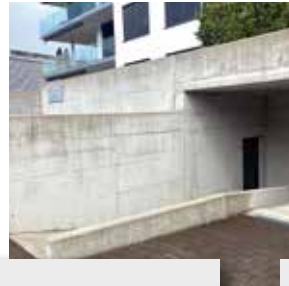
Vorher: Betonstützmauer mit Flechten- und Algenbefall. Nachher: Betonstützmauer ca. ein Jahr später.
