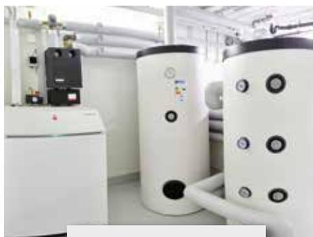
*Die komplette Anlage inklusive Pufferspeicher und Warmwasserspeicher versorgt im Einfamilienhaus alles, und zwar vom Heizkörper bis zur Fussbodenheizung.*
