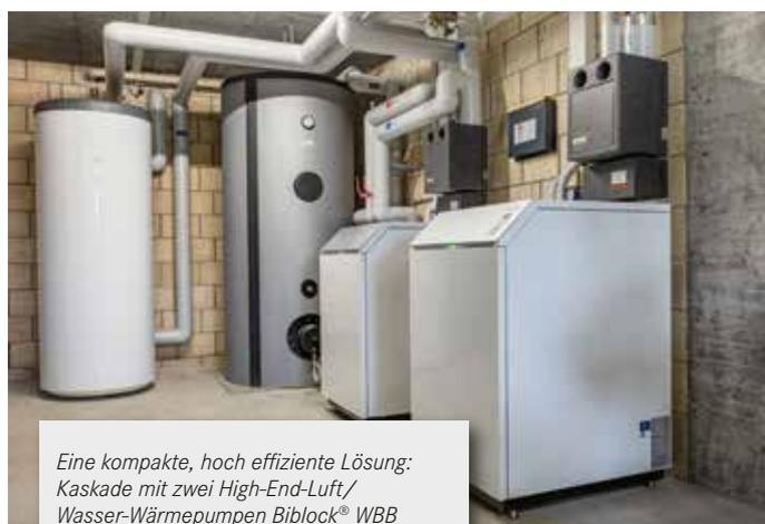
*Eine kompakte, hoch effiziente Lösung: Kaskade mit zwei High-End-Luft/Wasser-Wärmepumpen Biblock® WBB 20-A-RMD-AI, ergänzt mit einem Energiespeicher WES 500-HP und einem Trinkwasserspeicher WP/E 1000.*
