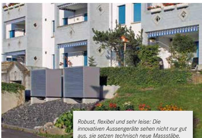
*Robust, flexibel und sehr leise: Die innovativen Aussengeräte sehen nicht nur gut aus, sie setzen technisch neue Massstäbe. Der flüsterleise Eulenflügel-Ventilator und der grossflächige BlueFin-Verdampfer reduzieren die Betriebsgeräusche auf ein Minimum.*
